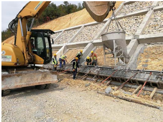
Izgradnja autoceste - roštiljska konstrukcija
